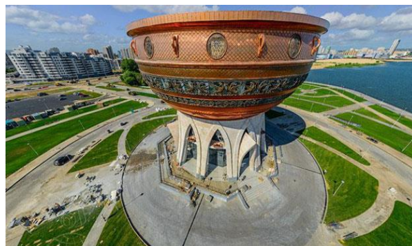
Рисунок 2. Строительство Центра семьи «Казань» и благоустройство набережной, г. Казань
